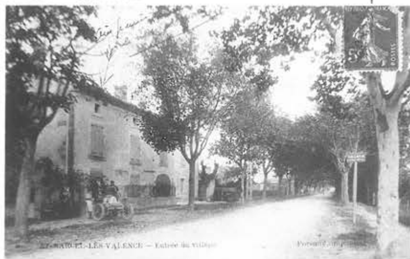
L'entrée du village, côté sud
