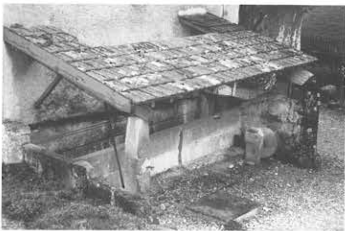
Bassin lavoir public
