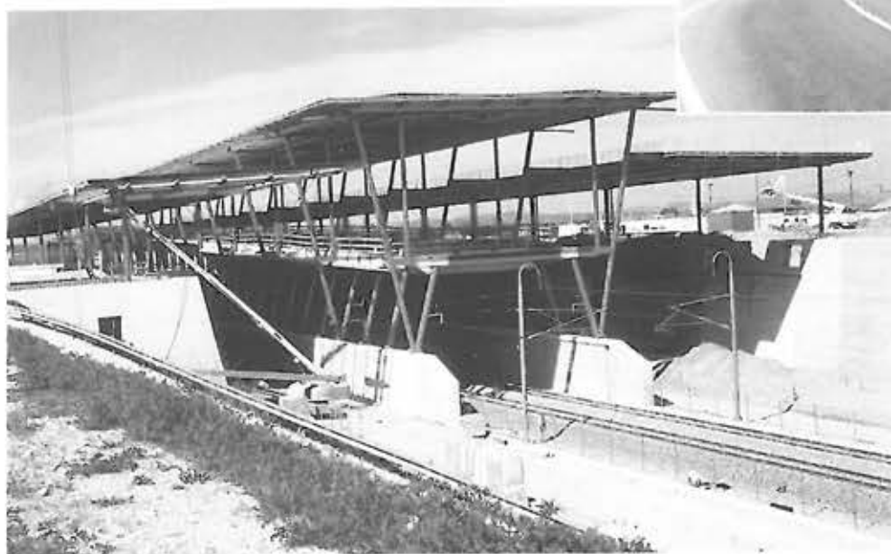
Gros œuvre de la nouvelle gare TGV
