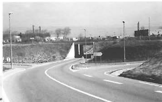
Passage de la route de Châteauneuf sous la ligne du TGV avant son raccordement sur la déviation du village
