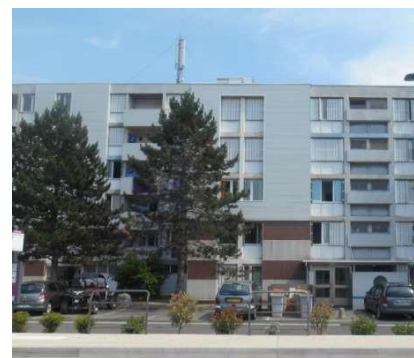
Construction de logements sociaux (DAH)
