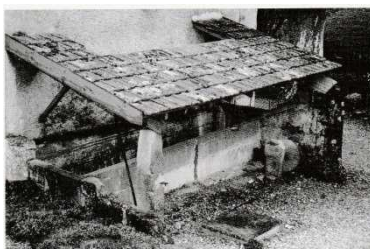
Bassin lavoir public
