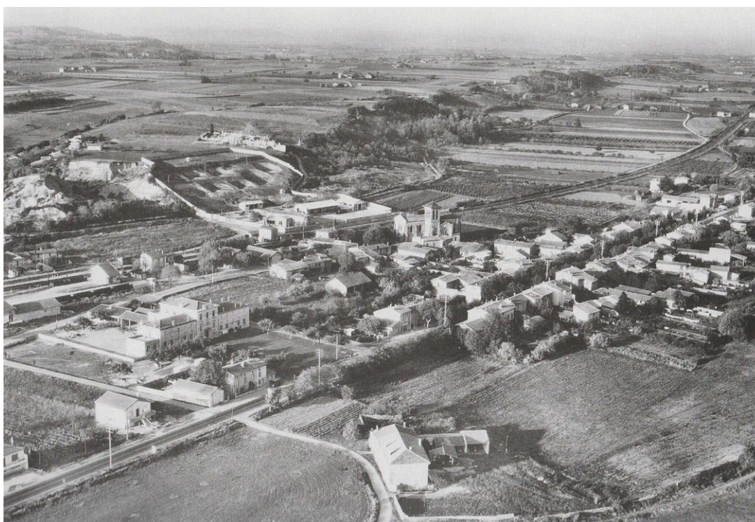
Vue aérienne sur le Village, 1955
